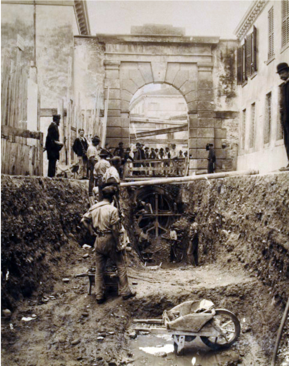
Lavori di costruzione della galleria alla Dogana, 1891 (BCVr)
